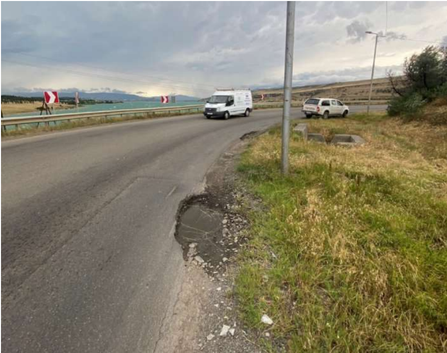
ნახ.3 თბილისის ზღვის შემოვლითი გზაზე დაზიანებული ასფალტ-ბეტონის საფარი მრუდე მონაკვეთზე, რომელიც განსაკუთრებული ხიფათის წყარო შეიძლება იყოს.
