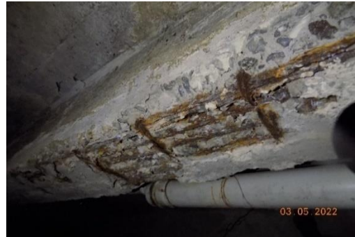
სურ. 1. დაზიანებული და ღრმად კოროზირებული ლითონის ელემენტები რკ/ბ რიველში
