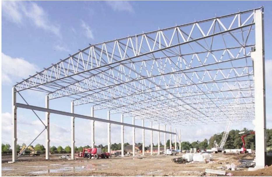
ნახაზი 10. გადახურვის ფოლადის მზიდი კონსტრუქციები - ა) ფოლადის ბრტყელი ტრაპეციული ფერმები
