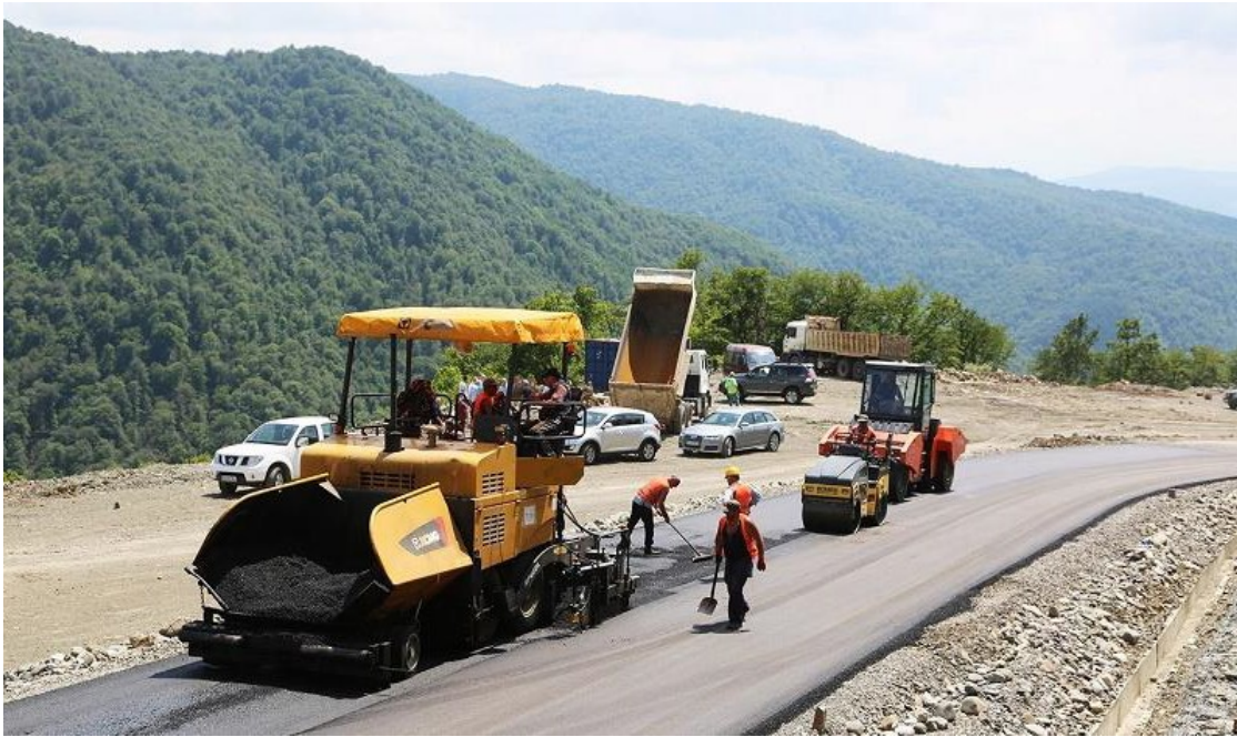
ნახ. 22. ზარიძეები-ყინვალის გზის მშენებლობა მინერალური ბოჭკოების ბაზაზე დამზადებული ბადე-ქსოვილების გამოყენებით
