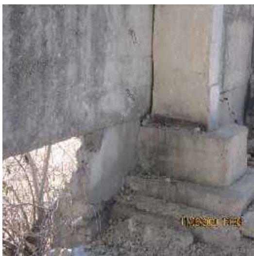
სურ.11. ფასადის დაზიანებული საკედლე პანელის ფუძის ფრაგმენტი
