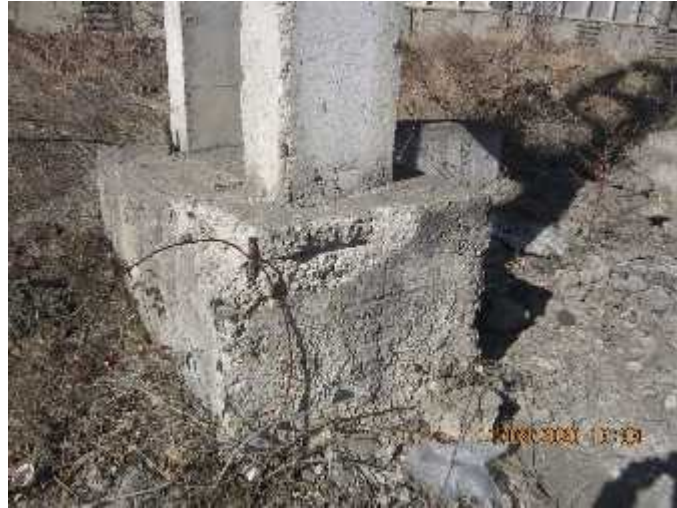
სურ. 19. დაზიანებული საძირკველი
