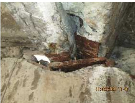
სურ. 17. გადახურვის ფილის დაზიანება წამწესთან შეერთების ლითონის კვანძში
