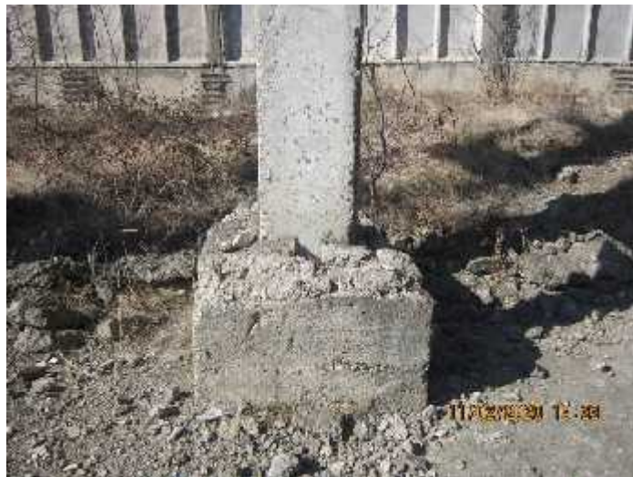
სურ. 20. დაზიანებული საძირკველი
