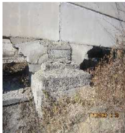
სურ.12. ფასადის დაზიანებული კედლის ფუძის ფრაგმენტი
