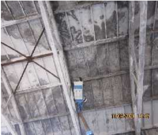
სურ. 15. გადახურვის დაზიანებული ფრაგმენტი
