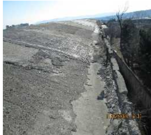
სურ. 15. გადახურვის დაზიანებული ფრაგმენტი
