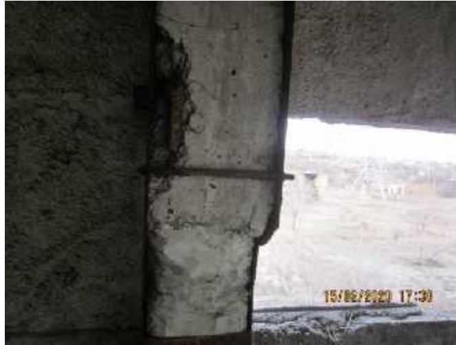
სურ. 22. მექანიკურად დაზიანებული სვეტი ლითონის ჯავშნით
