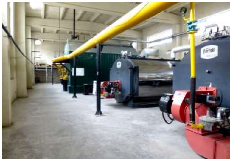
სურ. 3. იტალიური ფირმა „Ferrolli“-ს მიერ წარმოებული კვანძები გაჯერებული ორთქლის მისაღებად
