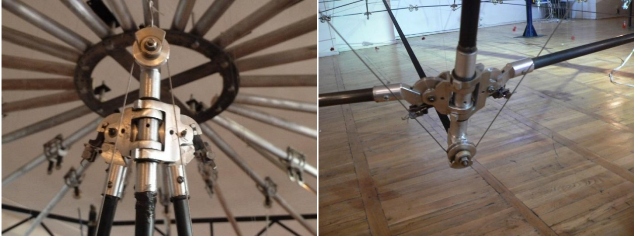
fig. III.43 _ “Casatex” Reroebiani, zambarebiT gasaxsneli refleqtoris gamSleli rgolis dgaris boloebSi ganTavsebuli, transformaciis procesSi sirceSi orientirebuli kvanZebis, “Casatexi” Reroebis gaxsnisas sinqronizaciis da gaSlis mastabilizebeli sistemis bagirebis da maTi Semotarebis gorgolaWebis fotoebi.
