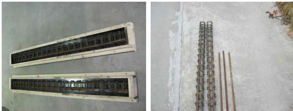
ნახ. 43 არმატურის კარკასები რკინაბეტონის კოჭებისათვის
