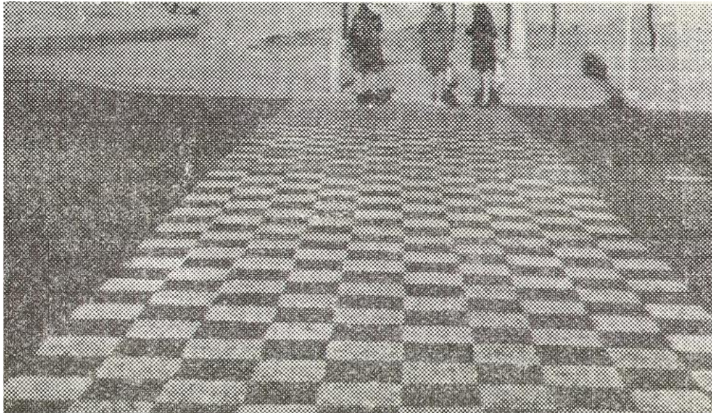
ნახ. 2. თეთრი კომპოზიციური ფენილის საერთო ხედი, რომელიც ჭადრაკულად განლაგებულია გადასასვლელის მონიშვნის მიზნით.
