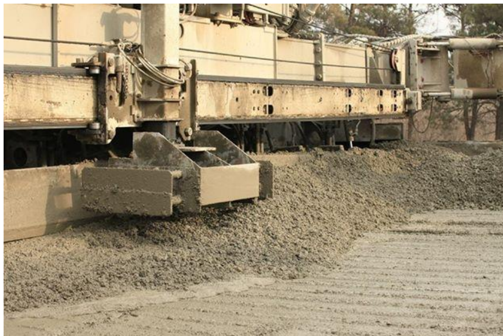
ნახ.19. ბეტონის მოსაპირკეთებელი მანქანის D 376.
