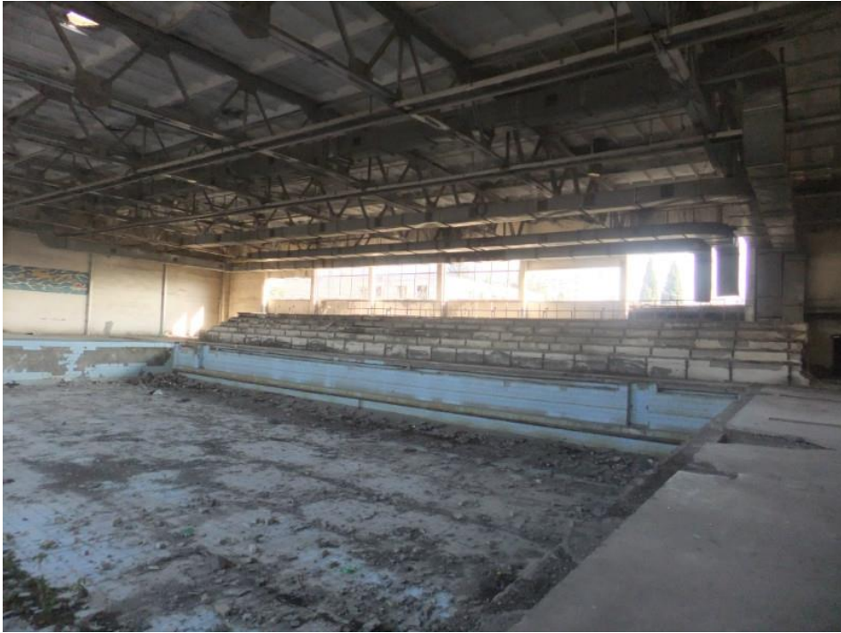
foto-suraTi 1.2.5 rusTavis daxuruli sacrao auzis savalalo saeqspluatacio mdgomareoba rehabilitaciamde.
