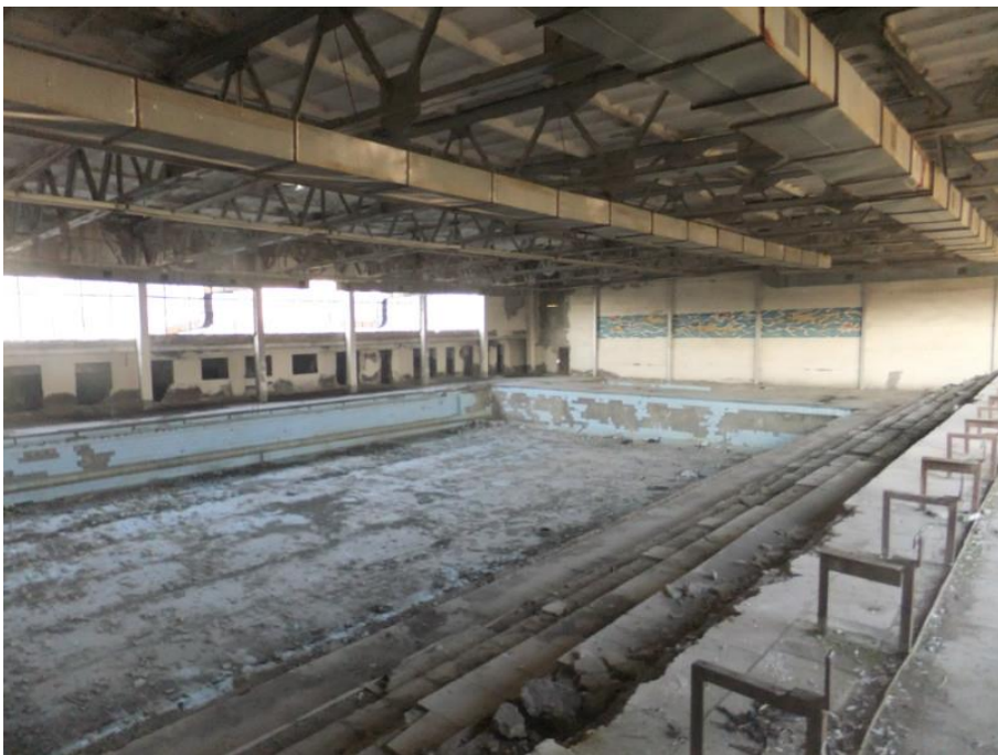
foto-suraTi 1.2.6 rusTavis daxuruli sacrao auzis savalalo saeqspluatacio mdgomareoba rehabilitaciamde.
