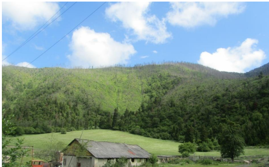
ფოტო 2.2.4 მტს-ის ხევის არეალში არსებული ენერგო ინფრასტრუქტურა (ელექტრო ენერჯის ტრანსფორმატორი და მაღალი ძაბვის ელექტრო სადენები)
