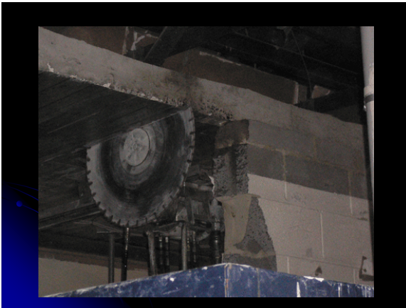
აღმასკომპოზიციური მასალისაგან დამზადებული ინსტრუმენტების გამოყენება ბეტონისა და რკინაბეტონის ჭრის ოპერაციებზე
