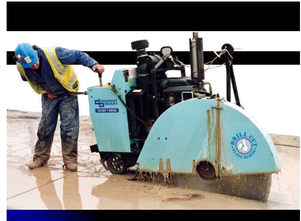
აღმასკომპოზიციური მასალისაგან დამზადებული ინსტრუმენტების გამოყენება ბეტონისა და რკინაბეტონის ჭრის ოპერაციებზე
