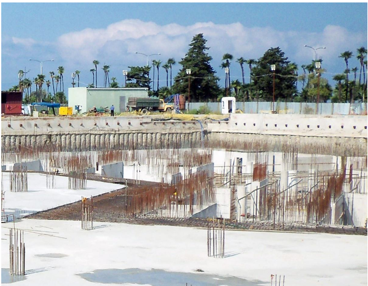
ნახ. 12 ბეტონის შეპირაპირების ზონა. "ჰილტონის" სასტუმრო. ქ. ბათუმი. პროექტის სახელწოდება: 'Black Sea Hotel & Residences'
