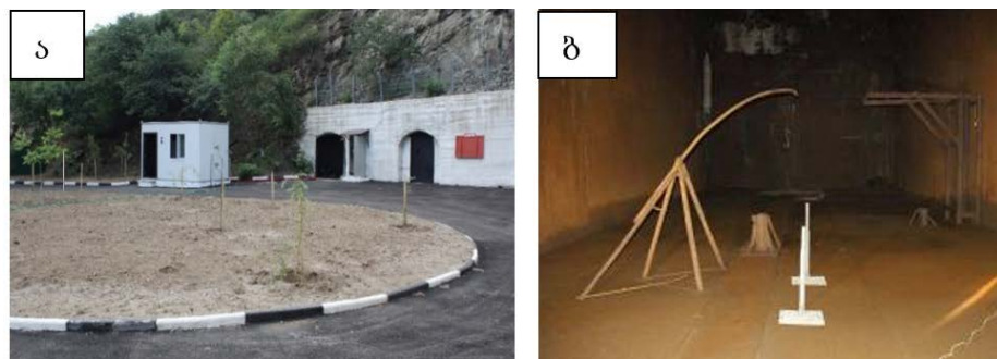
ნახ.3 მიწისქვეშა გვირაბთა კომპლექსის პორტალი (ა) და აფეთქების კამერა (ბ)
