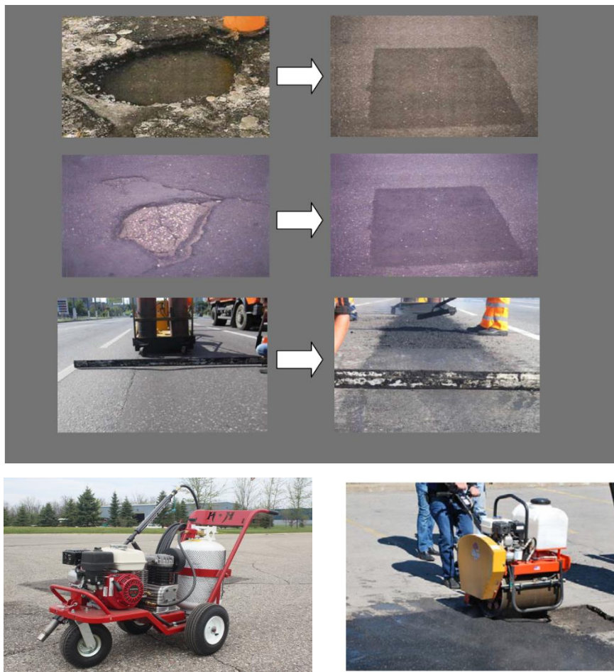
ნახ. 1 ასფალტბეტონის საფარის ორმოული შეკეთების პროცესი ინფრაწითელი გამოსხივების გამოყენებით
