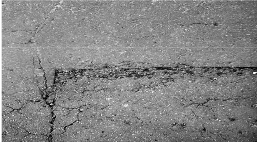
ნახ. 4. ასფალტბეტონის დანგრევა ორმოში, საფარის საკონტაქტო ზონაში
