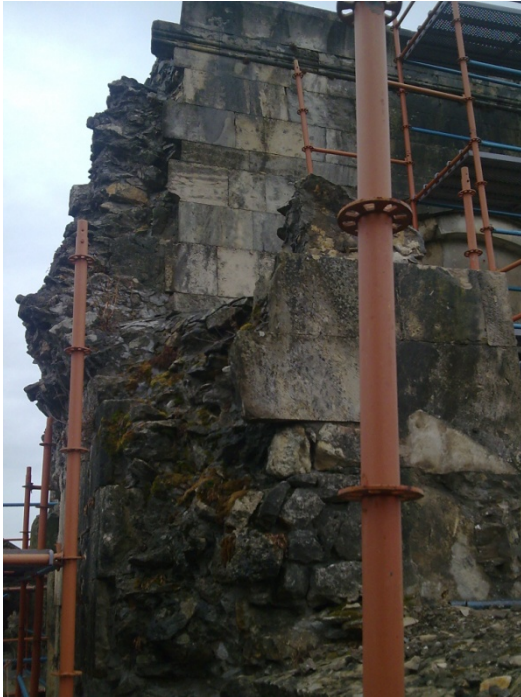
ნახ.3. დასაცემენტებლად გამზადებული კედლის ფრაგმენტი.
