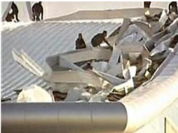
ფოტო-სურათი 1. თბილისის საერთაშორისო აეროპორტის ქარისაგან დაზიანებული სახურავი.
