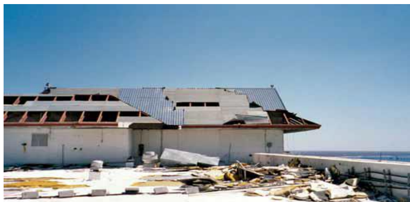
ფოტო-სურათები 3. აშშ-ს ქალაქ ზაიდოქსში 100 მეტრი სიმაღლის სასტუმროს ქარისაგან დაზიანებული სახურავი.
