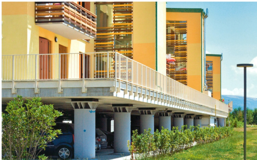
ნახ.4. YSO SLAB-ის ტექნოლოგიით აგებული შენობა
