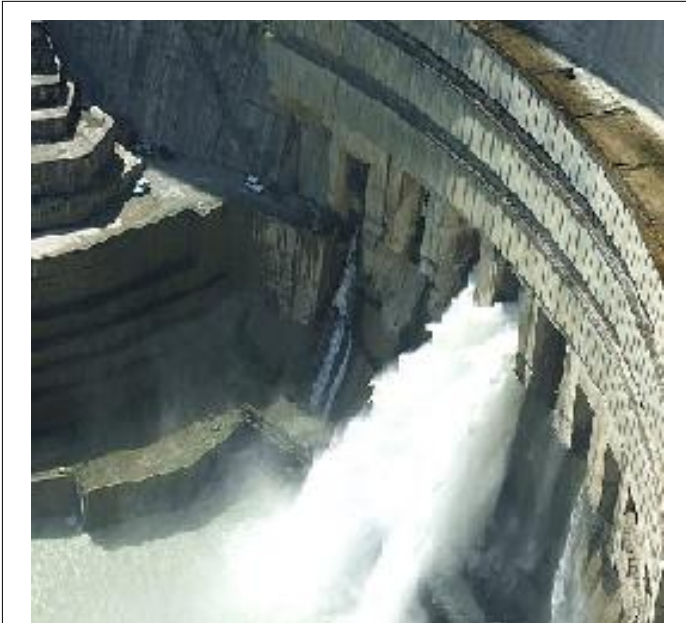
ნახ. 2.51. ევროპაში უმაღლესი (271,5 მ) ენგურჰესის კაშხალი: ექსპლუატაციის განვლილ პერიოდში პროცესები ისე განვითარდა, რომ დისკური საკეტების მიწისქვემა სათავის ასაქცევი გვირაბიდან დაახ-ლოებით 15 მ 3 /წმ წყალი იკარგებოდა ფილტრაციის გზით. ცემენტაცი-ის სამუშაოები ჩატარდა მსოფლიო ბანკის მიერ გამოყოფილი კრედი-ტის ფარგლებში 2006-2007 წლებში, რომლის შედეგადაც წყლის კარგვა შეწყდა
