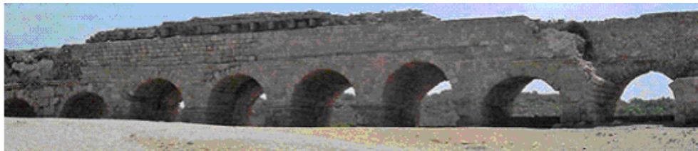
ნახ. 2.43. უძველესი რომაული აკვედუკი, რომელიც ახლაც კარგ მდგომარეობაშია. აკვედუკი ფაქტობრივად წყალსადენს წარმოადგენდა, რომლითაც ხდებოდა დასახლებული პუნქტების წყლით მომარაგება. წყალი მიედინებოდა ხიდისებრი ნაგებობის სივრცეზე, ზედა ნაწილში
