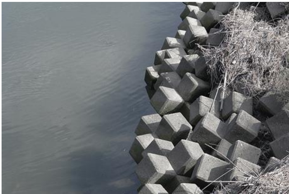
ნახ. 2.76. ტეტრაპოდებით ნაპირების გამაგრება კუნძულ სიკოკუზე (ფოტო, კოლამა)
