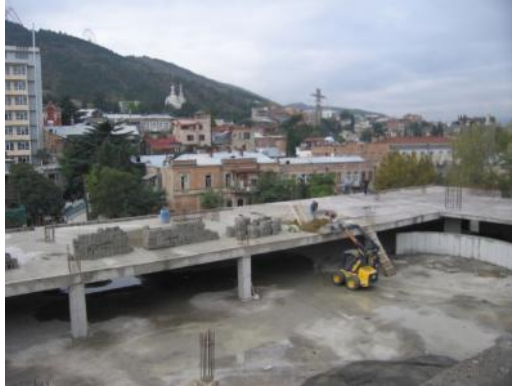
ნახ.1. “ბობ-კატის” გამოყენება ტვირთის მისაწოდებლად შენობის სახურავზე
