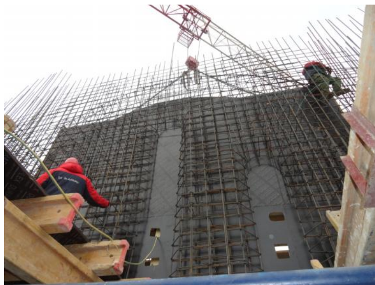
ნახ.3 სარკმლების ბლოკების არმირებულ კედელში ჩასადგმელი ადგილები
