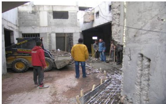
ნახ.2. ბეტონის მიწოდება შენობის შიგნით
