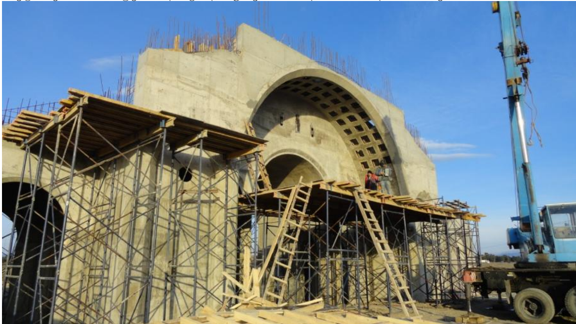
ნახ.3 კესონური გადახურვა დასრულებული სახით
