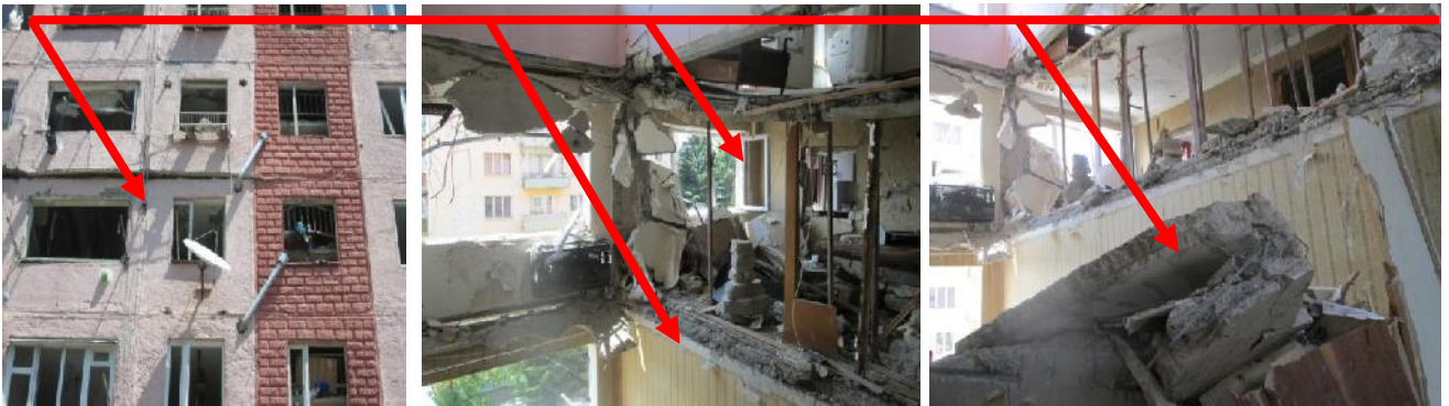
ფოტო 5. ბუნებრივი აირის აფეთქების შედეგად დაზიანებული №2 საცხოვრებელი კორპუსის IV სადარბაზოს მე-4, 5, 6, სართულების მდგომარეობა
