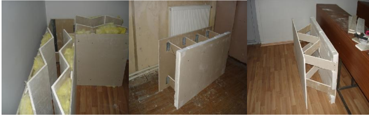
ნახ.1 საკედლე მოუხსნადი ყალიბები KNAUF-ის პროდუქციისაგან:
