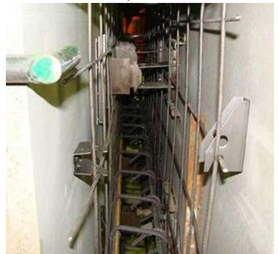
ნახ.2. ცემენტ-ბოჭკოვანი მოუხსნადი ყალიბი (ა) და ყალიბის შიდა და გარე კედლების შეერთება და არმირება (ბ)
