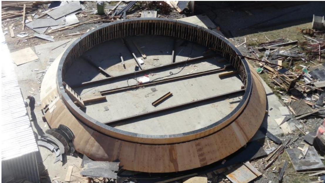
ნახ.3. დიდი გაბარიტული ზომის და მძიმე საყალიბე სისტემა გამყოფი ფანჯრებით ასეთ შემთხვევებში საყალიბე სისტემის გამყოფ კვანძებს აქვთ, ნახ.4-ზე მოყვანილი სქემატური სახე.
