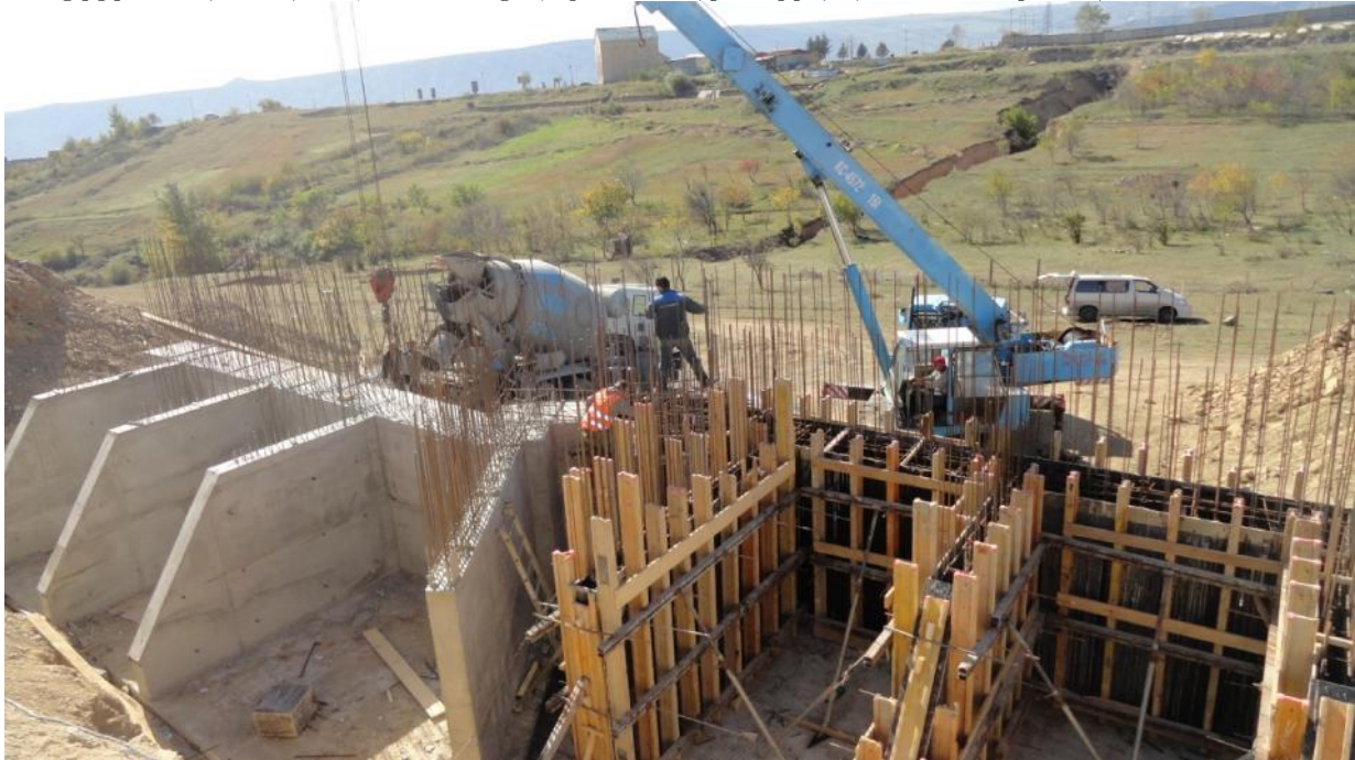
ნახ.1 რკინაბეტონის საყრდენი კედლის აგების პროცესი
