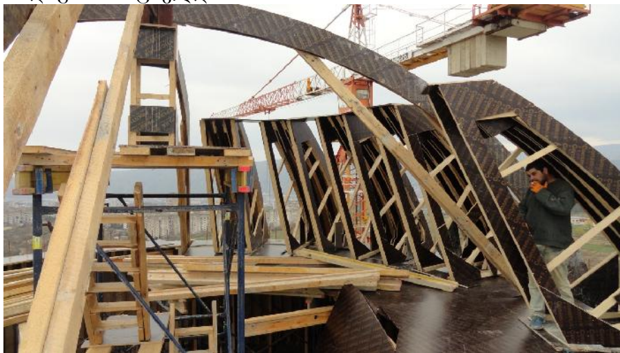
ნახ.2. გუმბათის ყალიბის მეორე დონის კარკასის ელემენტების მონტაჟი
