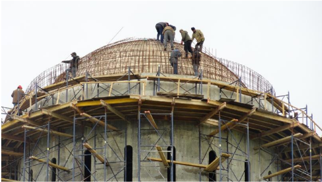
ნახ.3. გუმბათის დასრულებული ყალიბი და მისი არმირება
