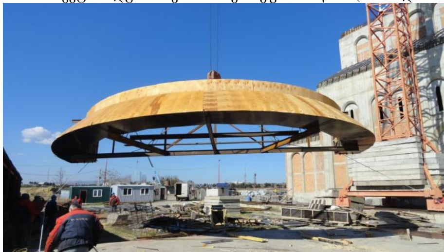
ნახ.3. საყალიბე სისტემის ერთი ნახევრის გადაადგილება კომპურა ამწით
