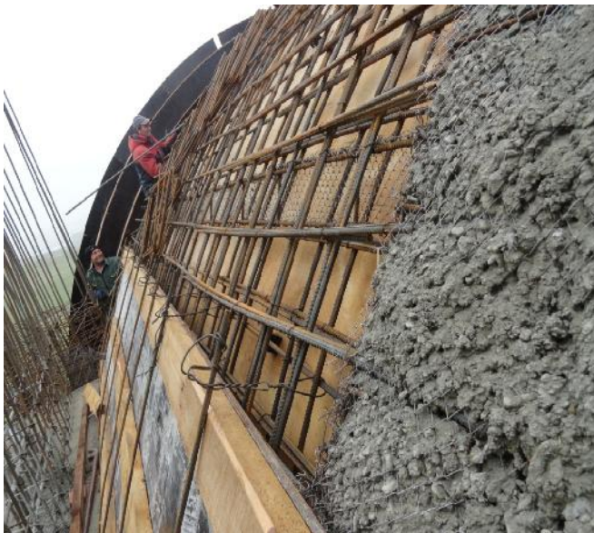
ნახ.2. ფანერის ყალიბის მოწყობა, ფიცრების სამაგრი არამატურის ღეროების განთავსებით
