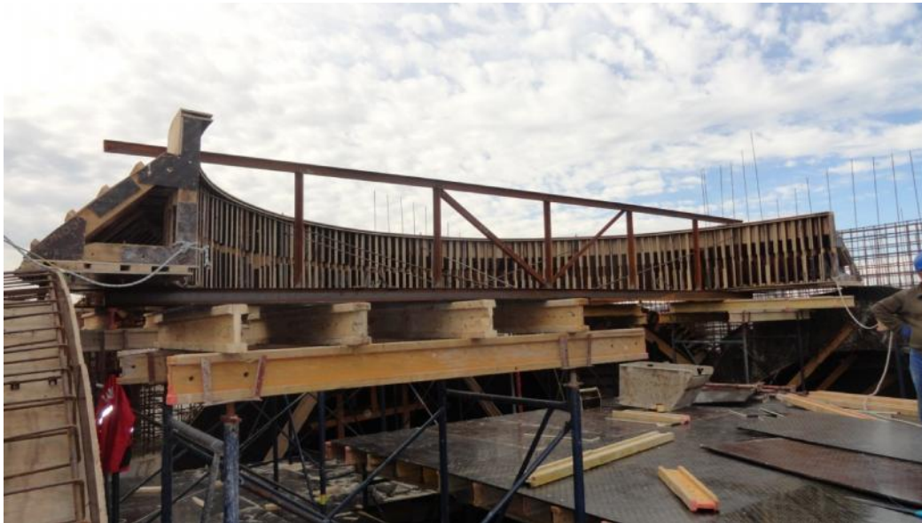
ნახ.4 ყალიბის პირველი ნახევრის დამონტაჟება საპროექტო მდგომარეობაში.
