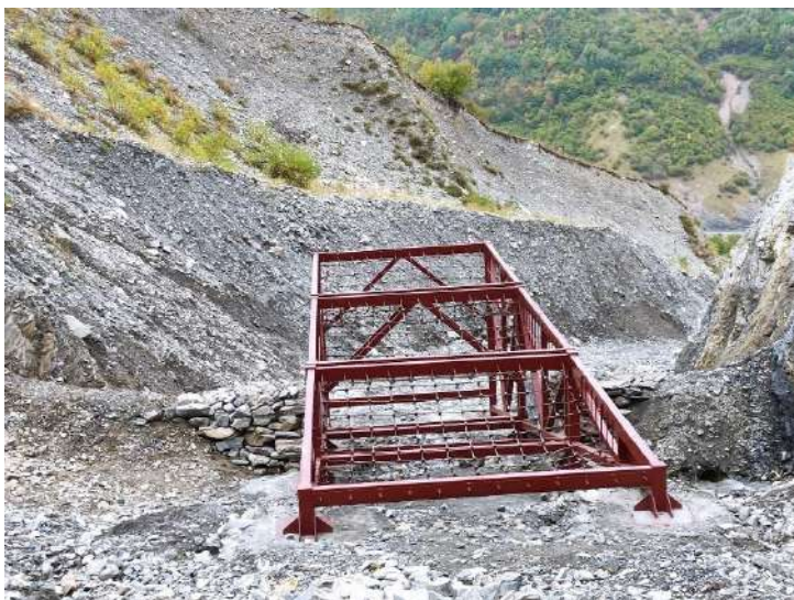
ფოტო 1. მდინარე მლეთის ხევის კალაპოტში რკინაბეტონის ფუნდამენტის მოწყობისას
