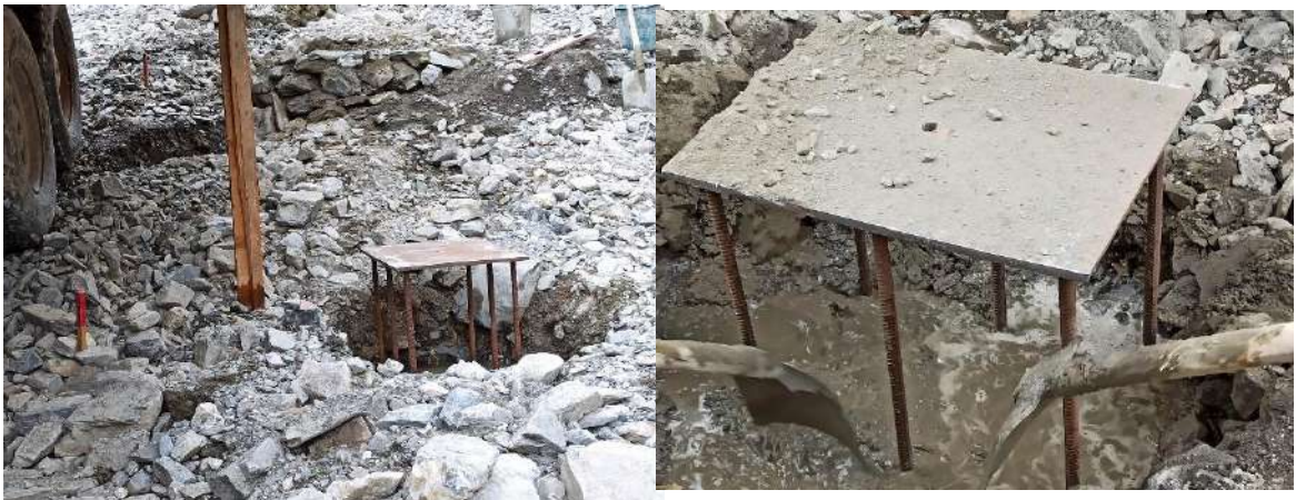
ფოტო 1. მდინარე მლეთის ხევის კალაპოტში რკინაბეტონის ფუნდამენტის მოწყობისას
