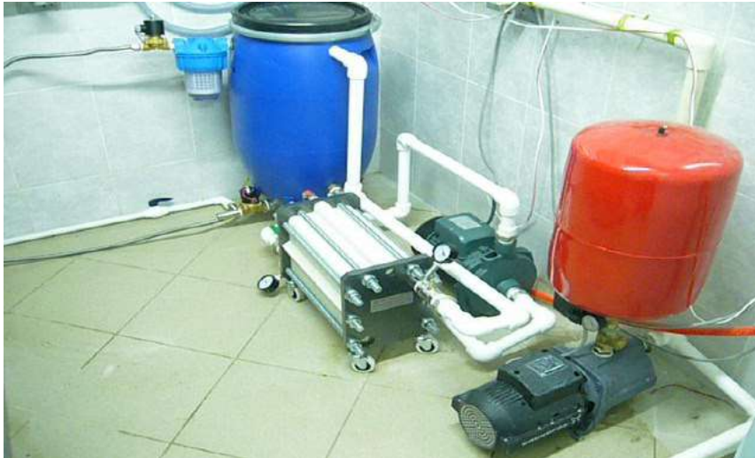
სურათი 5. შ.პ.ს. „ოქროს კათხაში“ დამონტაჟებული მტკნარი წყლის ულტრაფილტრაციული მემბრანული დანადგარი
